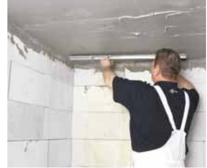
A felhordott Rimano/Rimat réteget „h” léccel simítjuk el a másik irányba
