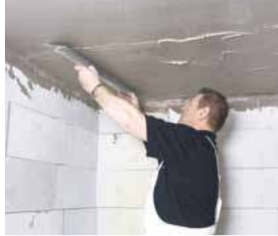
A felhordott Rimano/Rimat réteget „h” léccel simítjuk el az egyik irányba
