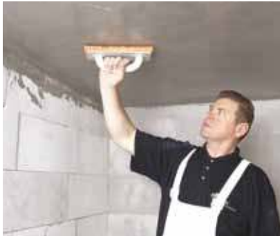
Rövid száradás után a felületet körkörös mozdulattal szivacsos simítóval átsimítjuk
