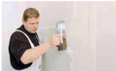
A hézagoló anyag szétterítése és elsimítása
