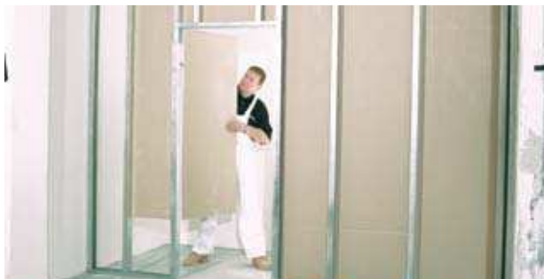
Falborítás szerelése – a válaszfal egyik oldala
