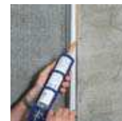
3. Hézagoló ragasztó felhordása a lapélekre
