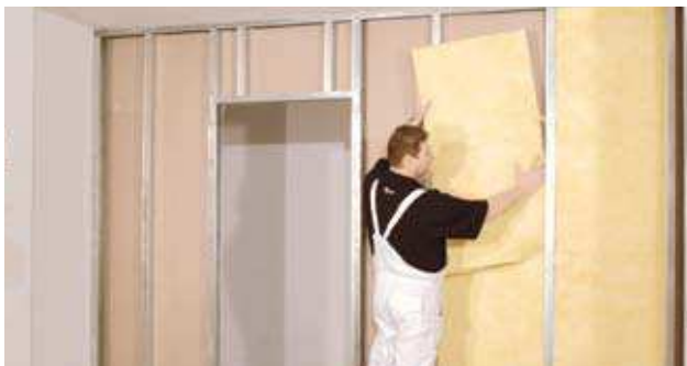
Ásványgyapot szigetelés elhelyezése a válaszfal üreges részében
