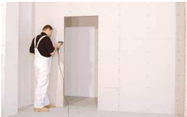
Falborítás szerelése – a válaszfal másik oldala
