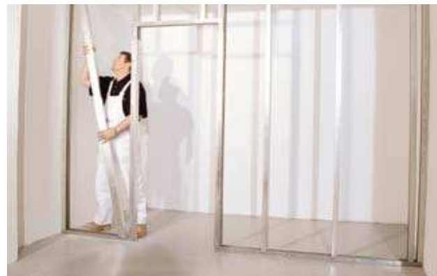
Válaszfal tartószerkezetének szerelése –függőleges CW-profilok
