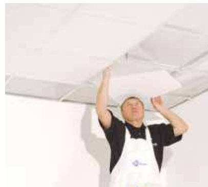
A kazettás álmennyezet behelyezése
