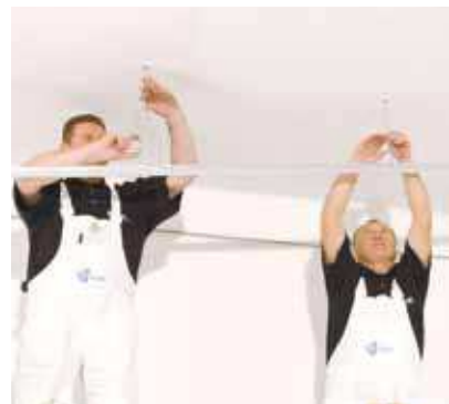
A főtartó (pl. CT24 vagy QT24) elhelyezése
