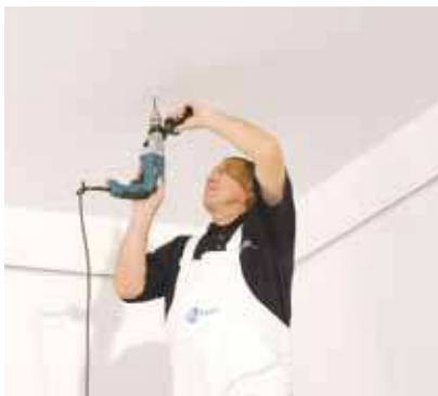
Függesztők rögzítése a teherhordó födémbe
