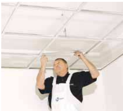
A 600 mm hosszú összekötők elhelyezése
