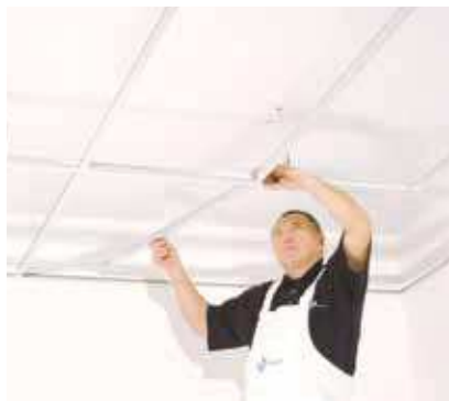
Az 1200 mm hosszú összekötők elhelyezése
