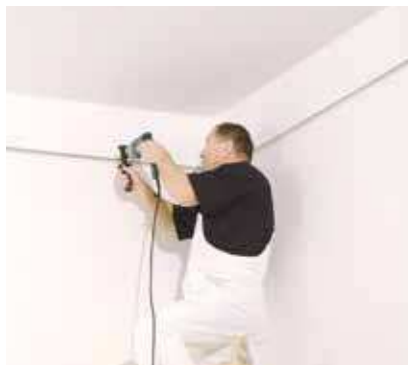
Falprofilok szerelése
