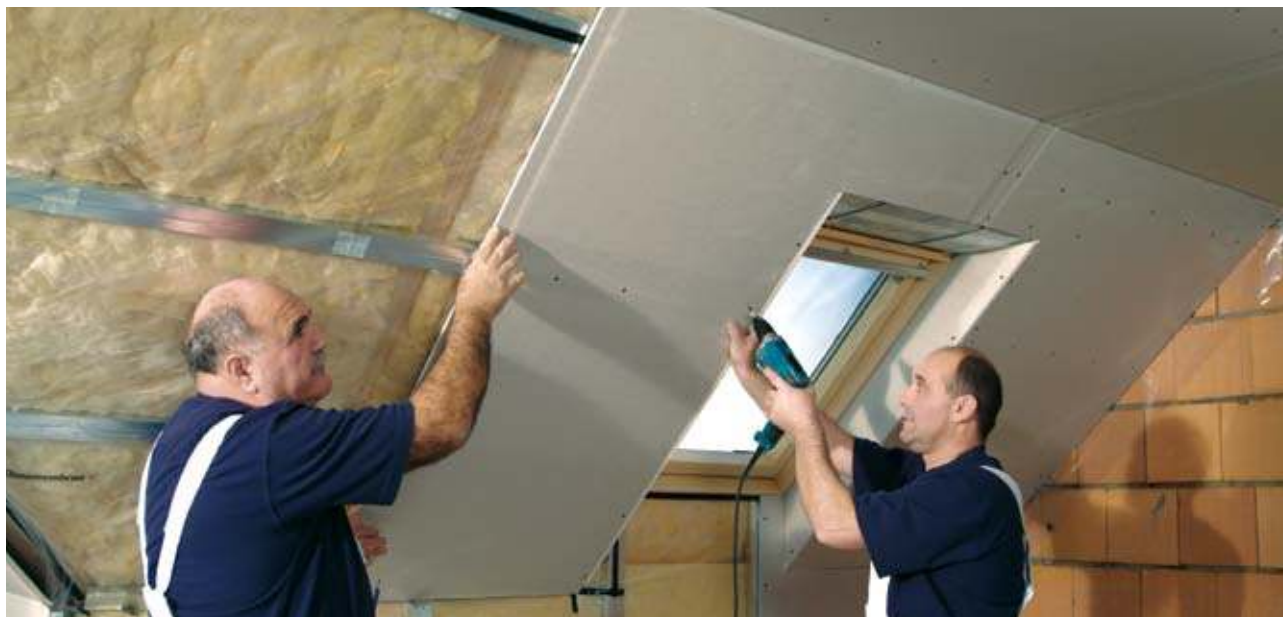
Gipszkarton lapok szerelése
