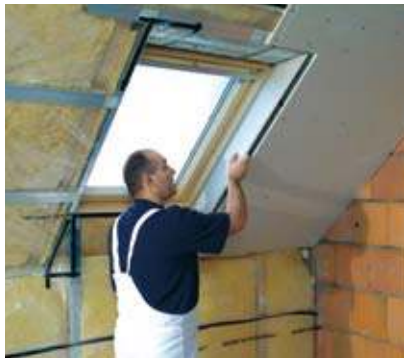
A lap ablakhoronyba történő behelyezése az ablak oldalsó részeinek burkolásánál
