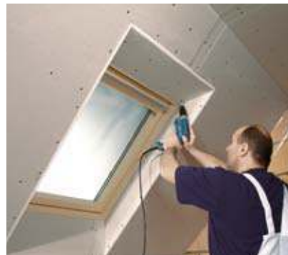
A szemöldökrész lapjának rögzítése a CD-profilba
