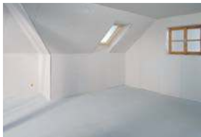
Tér a válaszfal megépítése előtt
