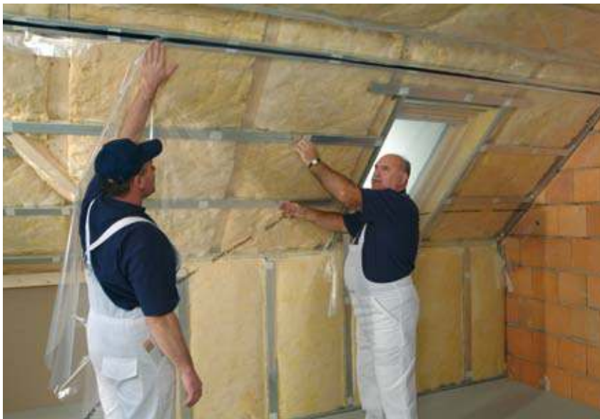
Párazáró réteg installálása – párazárás tartószerkezeten kívül
