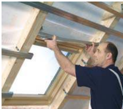
CD-profilt behelyezzük az UD profilba a szemöldökrésznél
