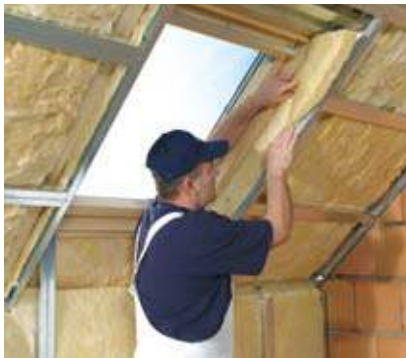
A hőszigetelés elhelyezése
