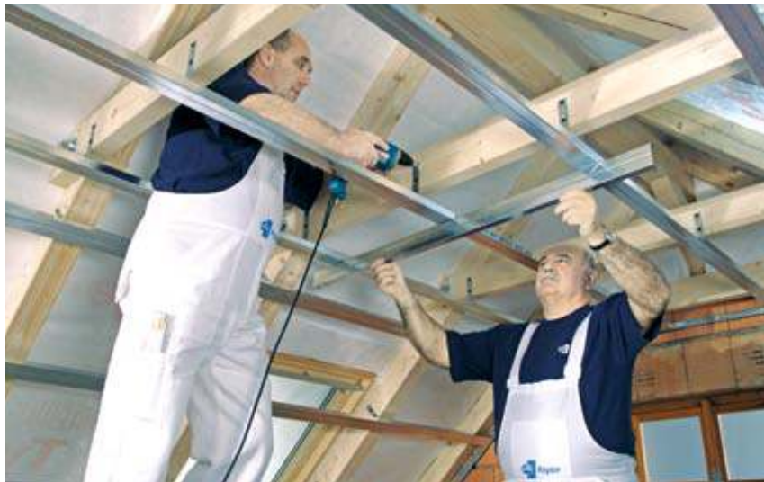
Vázszerkezet szerelése – szarufa-függesztő segítségével
