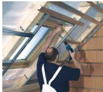
Alapszerkezet szerelése, az UD és CD-profilok összecsavarozása Opel csavarokkal
