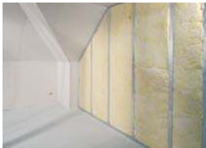
Az ásványgyapot szigetelés behelyezése
