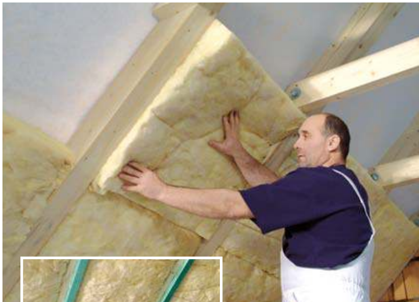
Hőszigetelés elhelyezése
