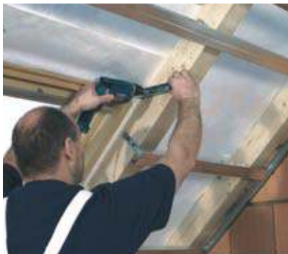
Az UD profilt a szarufához csavarozzuk
