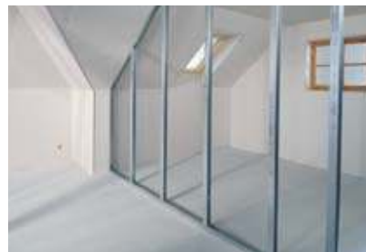
CW-profilok elhelyezése
