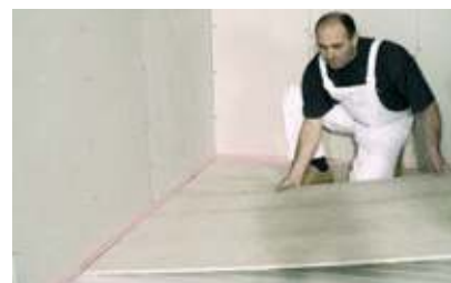
A második lapréteg elhelyezése
