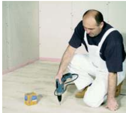
Elemek összecsavározása
