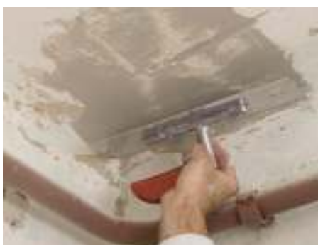
felújítás – kapart felület
