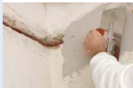
felújítás – hornyok kitöltése
