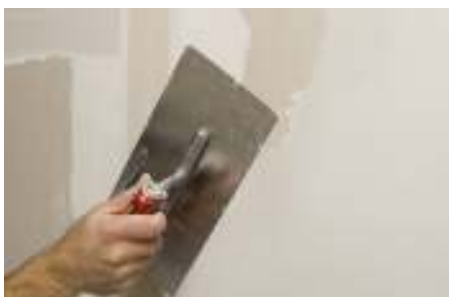
Rigips lapok teljes felületi glettelése
