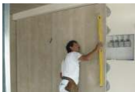
Rigips lapok végső helyére igazítása
