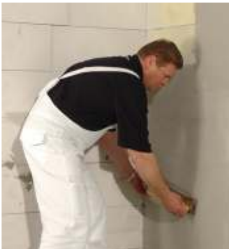
kézi felhordás pórusbeton falra
