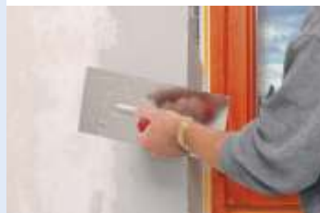
felújítás – nyílászáró csere
