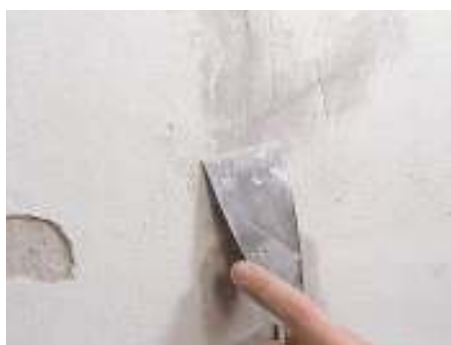
repedések, felületi hibák kitöltése
