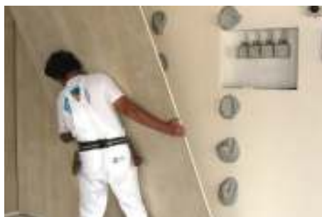
Rigips lap felragasztása falra
