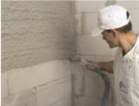
gépi felhordás pórusbeton falra
